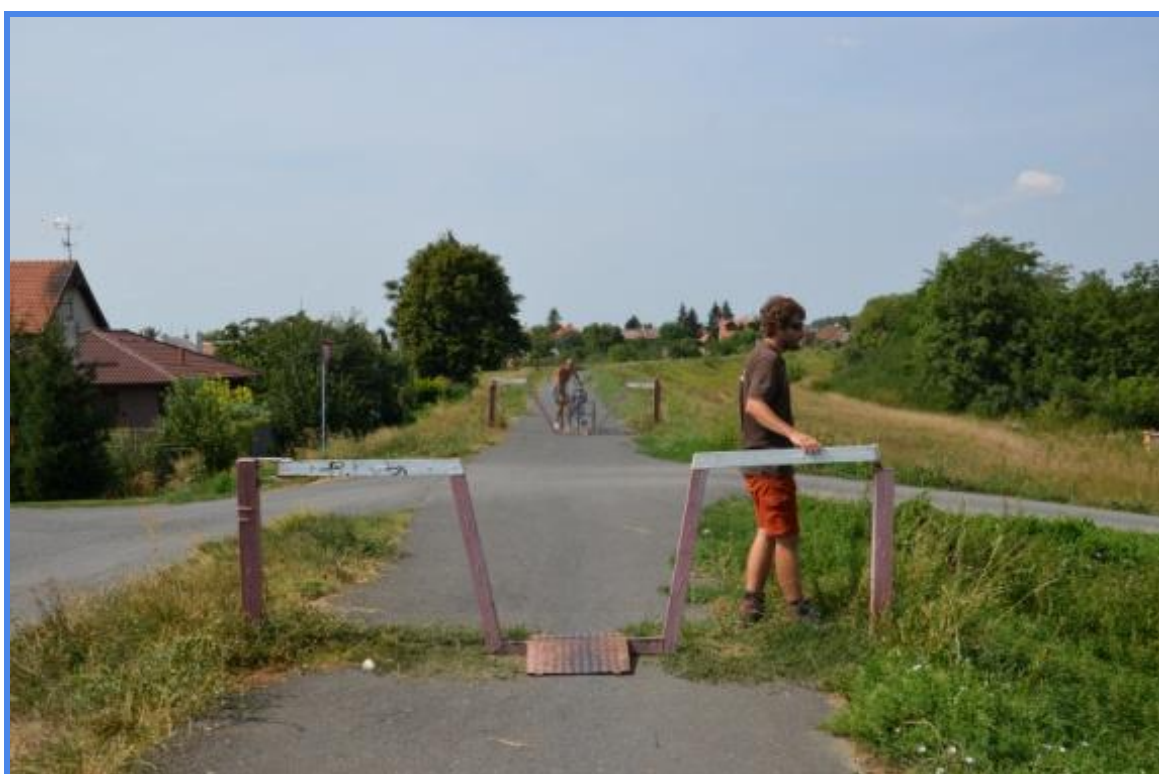
Obr. č. 32: Nevhodná cyklobránka pre invalidov (2. príklad)
