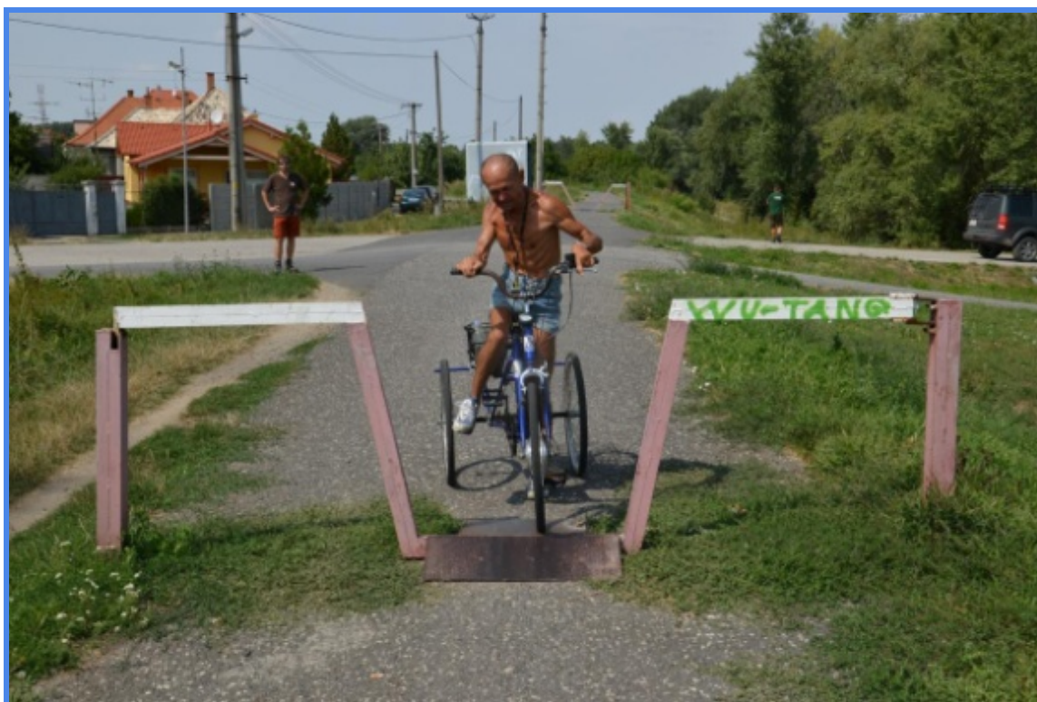
Obr. č. 31: Nevhodná cyklobránka pre invalidov (1. príklad)
