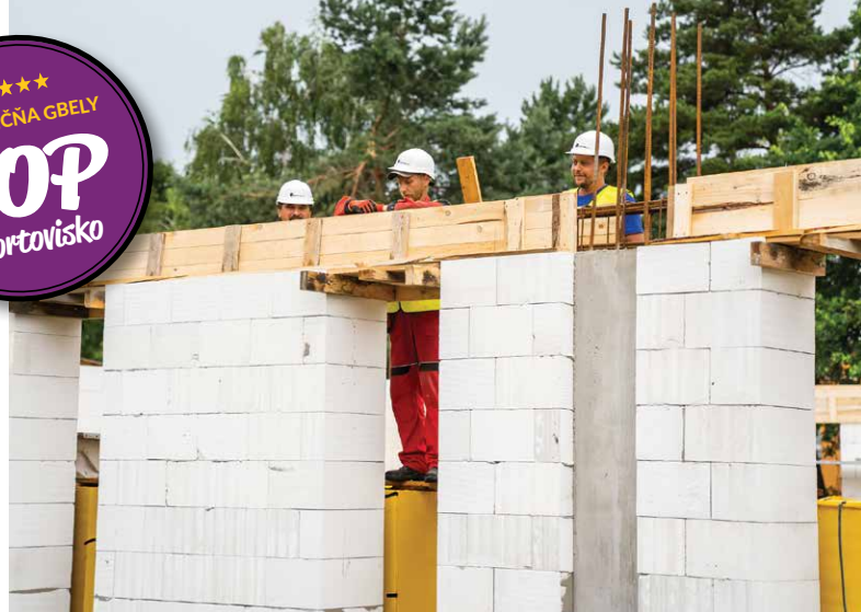
V súčasnosti už sú vystavané obvodové múry a momentálne prebieha debnenie vencov.
