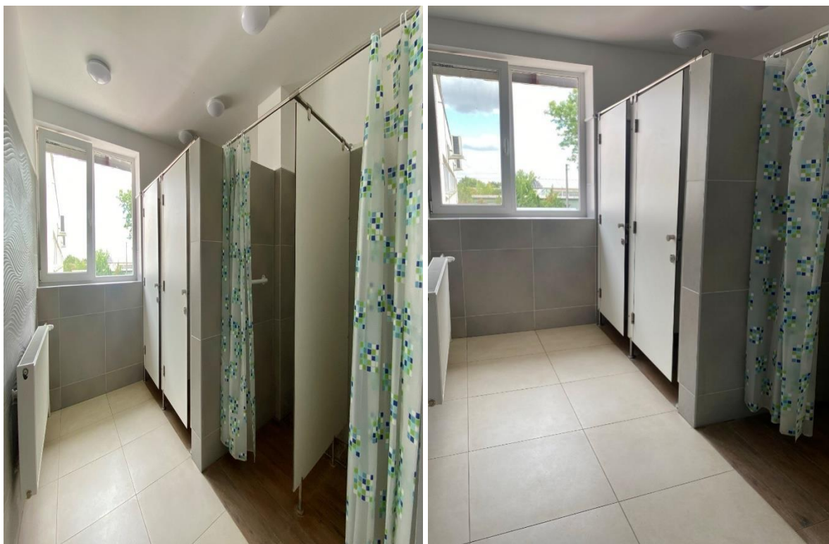
Obrázok č. 11-12 Rekonštrukcia sociálnych zariadení vrátane nevyhnutnej debarierizácie na I. poschodí.
