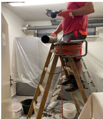
Výmena kanalizačných rúr v chladnom sklade
